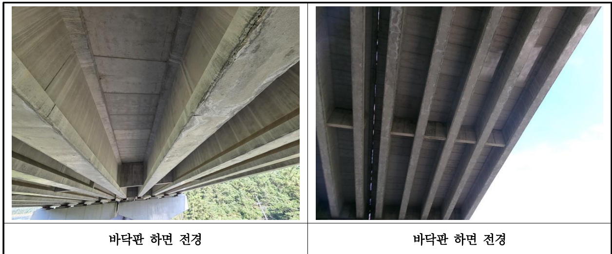
【사진 38.3.27】 바닥판하면 전경
