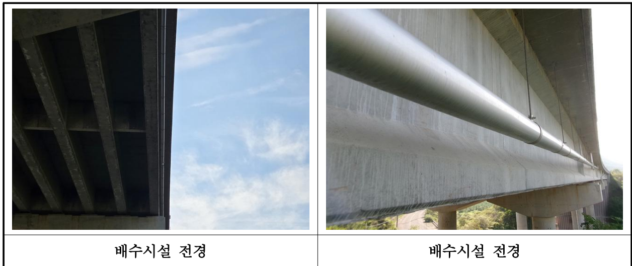
【사진 38.3.46】 배수시설 전경
