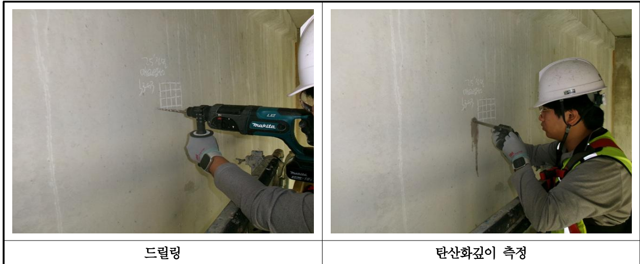
【사진 38.4.3】 탄산화 깊이 측정 현장사진
