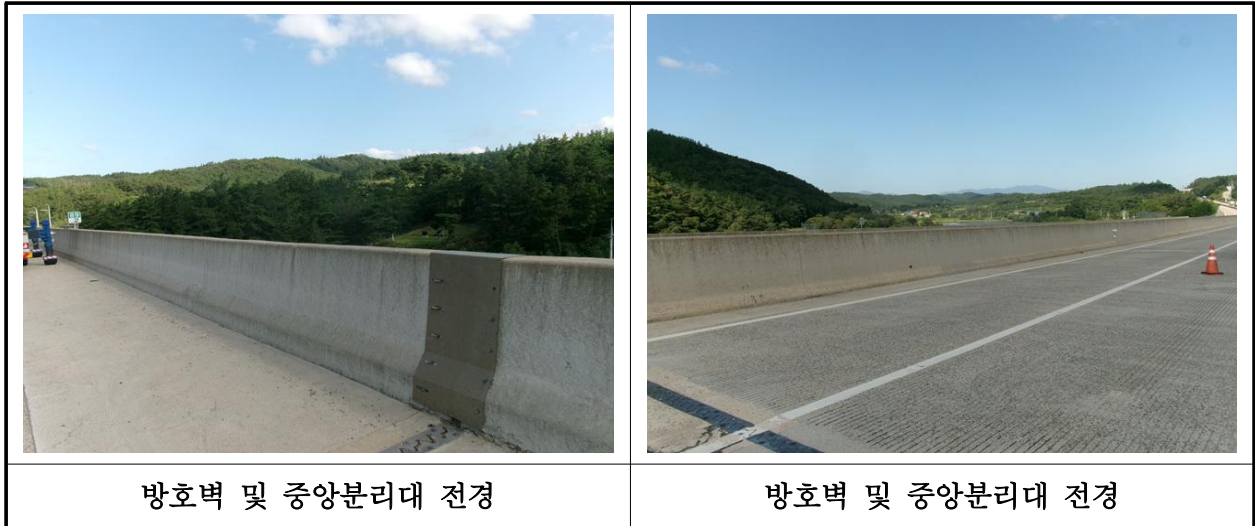
【사진 38.3.23】 방호벽 및 중앙분리대 전경
