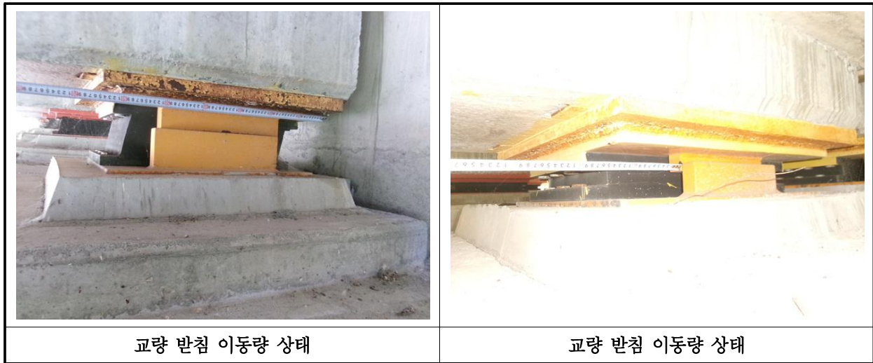
【사진 38.3.40】 교량받침 이동량 상태
