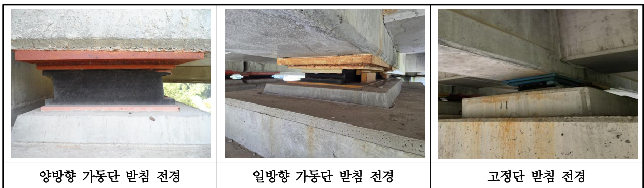
【사진 38.3.12】 교량받침 전경
