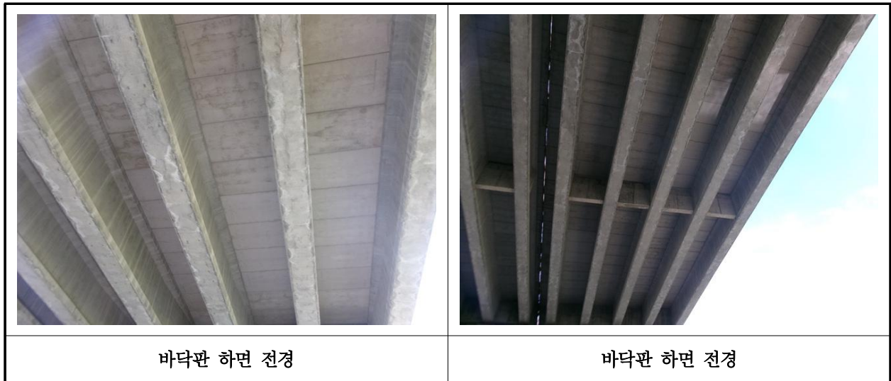
【사진 38.3.2】 바닥판하면 전경
