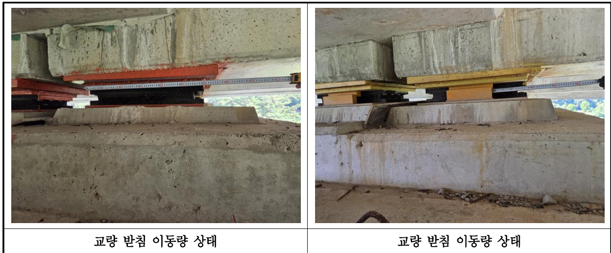
【사진 38.3.15】 교량받침 이동량 상태
