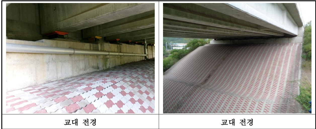
【사진 38.3.33】 교대 전경
