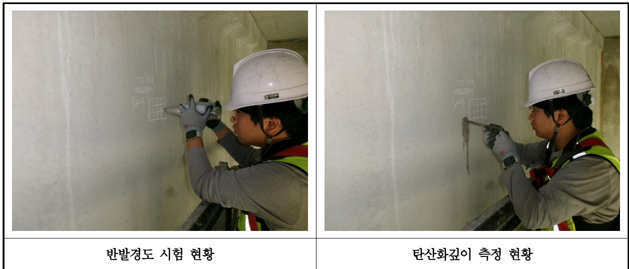
【사진 38.4.1】 콘크리트 내구성조사 현황
