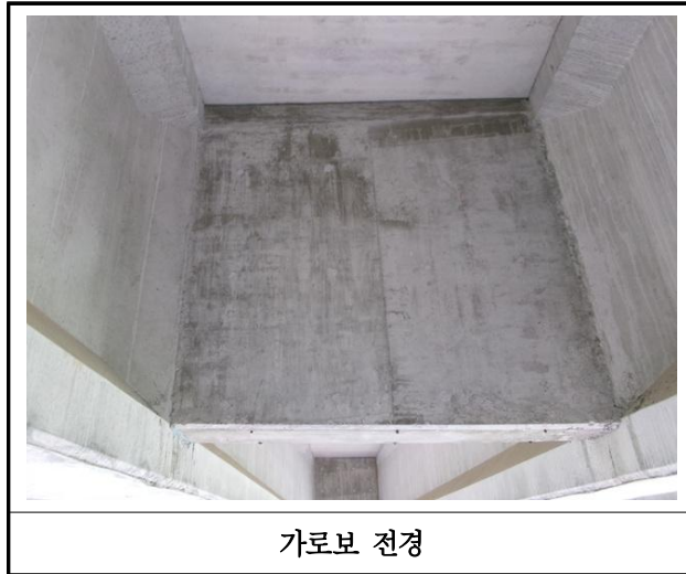
【사진 38.3.31】 가로보 전경
