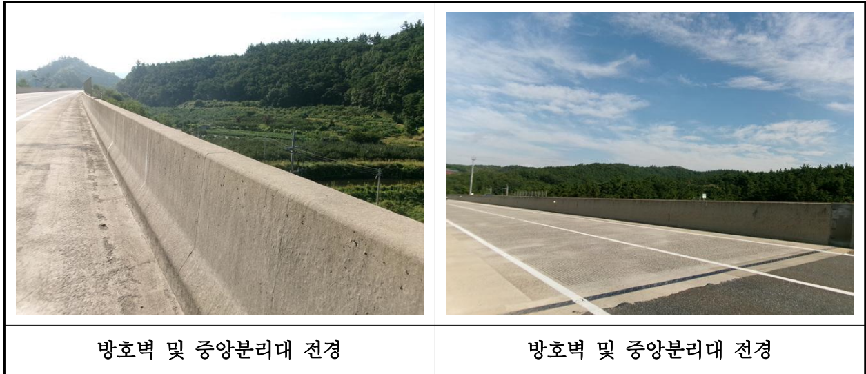
【사진 38.3.48】 방호벽 및 중앙분리대 전경
