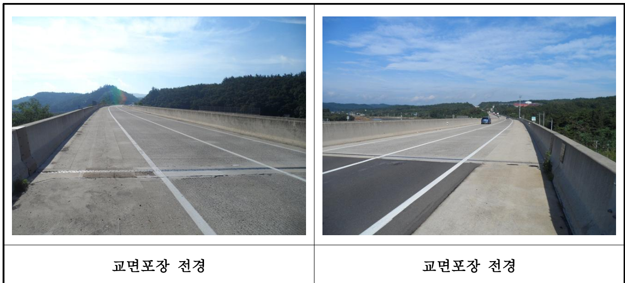
【사진 38.3.19】 교면포장 전경
