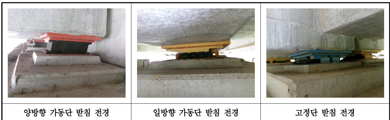
【사진 38.3.37】 교량받침 전경
