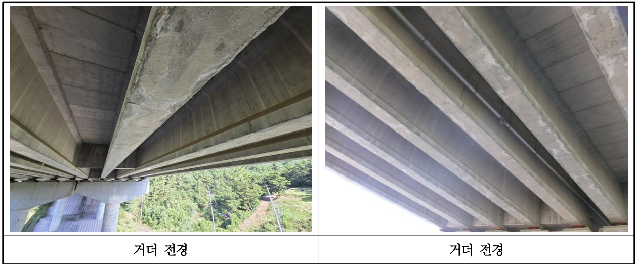
【사진 38.3.4】 거더 전경
