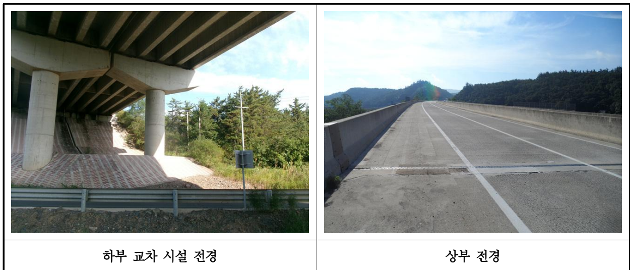
【사진 38.2.1】 부재 현장측정 전경
