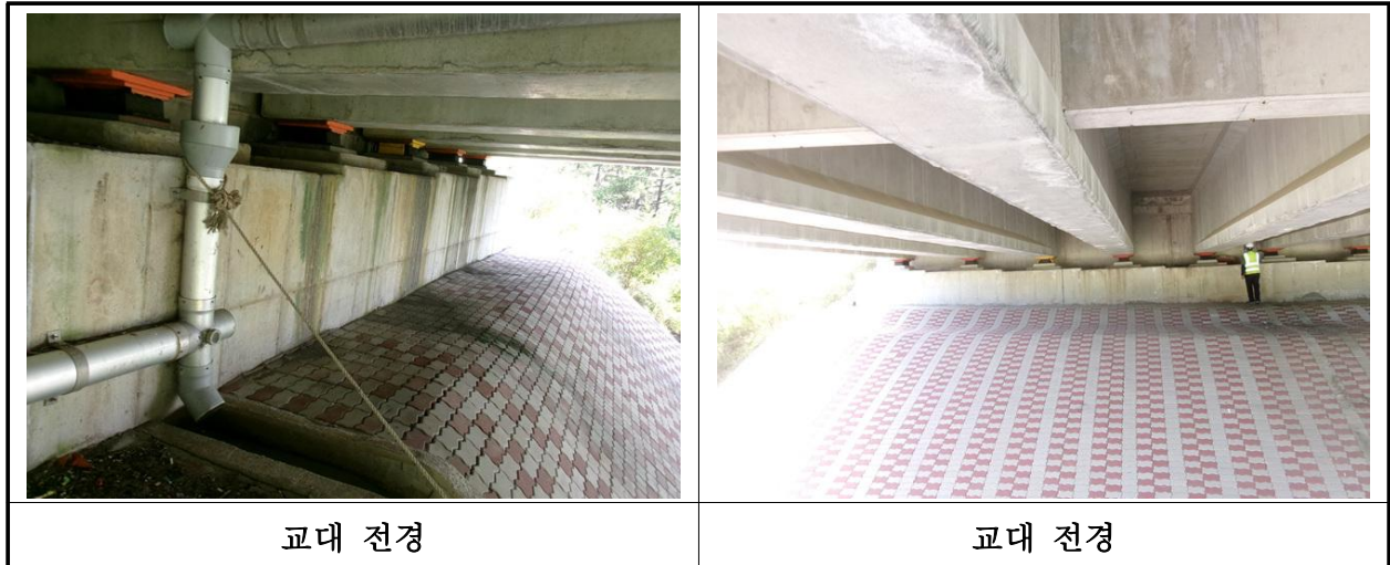
【사진 38.3.8】 교대 전경
