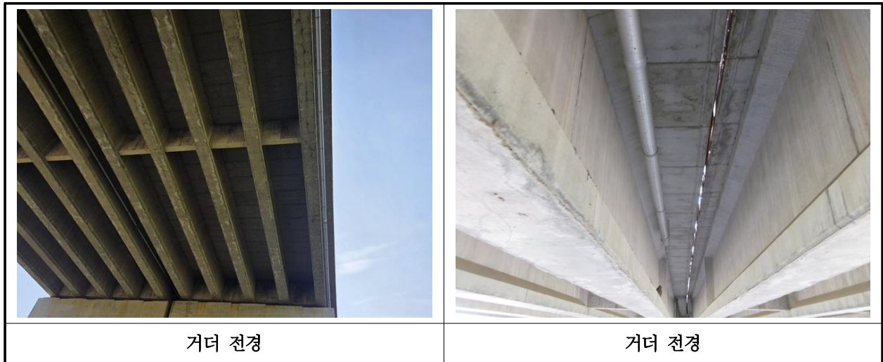
【사진 38.3.29】 거더 전경
